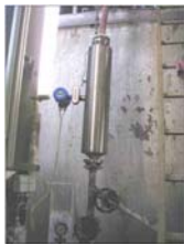
MEDICION DENSIDAD LECHADA DE CAL Densidad 1,07 a 1,2/Flujo Másico 50 T/h OPTIMASS 7300 T50
