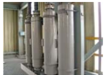
CUATRO DENSIMETROS MASICOS EN PARALELO FLUJO MÁSSICO 0 a 36 t/hr. OPTIMASS 7300-T80 IMPALA SUDAFRICA
