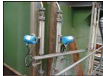
MEDICION FLUJO DE SALMUERA CONTROL DE DENSIDAD MINA DE SAL-AUSTRIA
