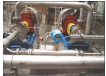
MEDICION FLUJO DE SALMUERA CONTROL DE DENSIDAD MINA DE SAL-AUSTRIA
